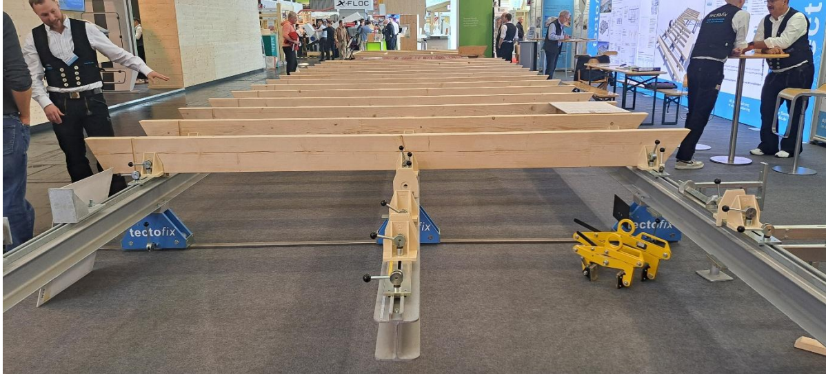
Sparrenlage eine Dachhälfte (Foto: Bauer Holzbau)
