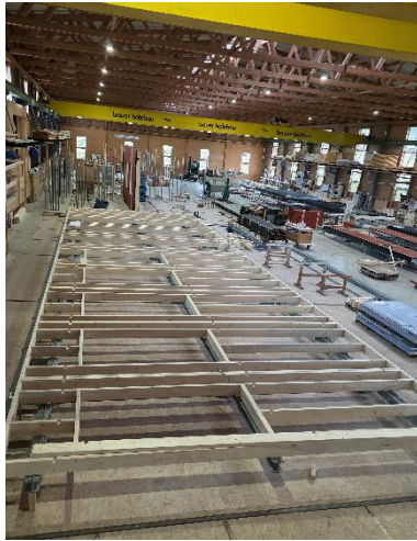
Ständerwerk (Foto: Bauer Holzbau)
