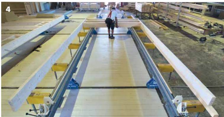
4 + 5 / Wandfertigung in idealer Arbeitshöhe
