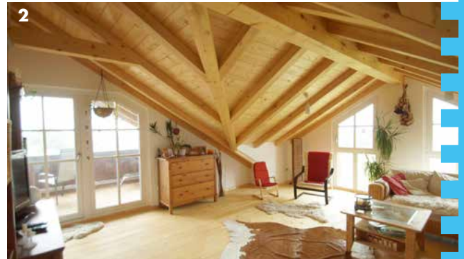
2 / Wohnhaus: Sichtdachstuhl mit Querbaukehle
