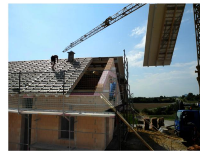
Dachfläche ca. 160 qm
